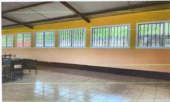
Foto1: Sustitución de ventanas; sistema de apertura: corredizas, perfiles color blanco estandar, Material del marco: PVC material de la ventana: vidrio, sellado perimetral.
