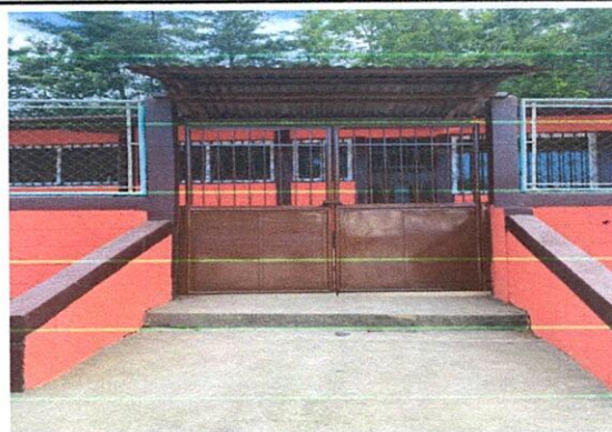
Foto 4: Mantenimiento a portón de ingreso, material: metálico, incluye: bisagras y sistema de cierre.
