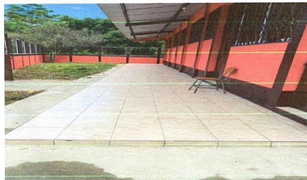
Foto 6: Sustitución de piso de concreto de acabado liso por piso cerámico en la cocina y corredor.
